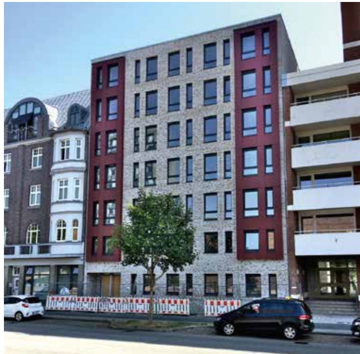
Macht eine gute Figur: das neue Wohnheim in der Feldstraße in Kiel, das bald bezogen werden kann.
